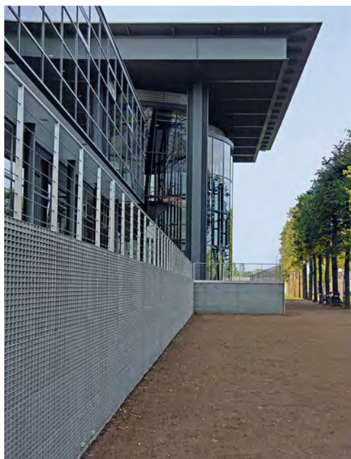
Am Sächsischen Landtag in Dresden ist der dem Elbufer zugewandte Betonsockel mit Gitterrosten verkleidet.
