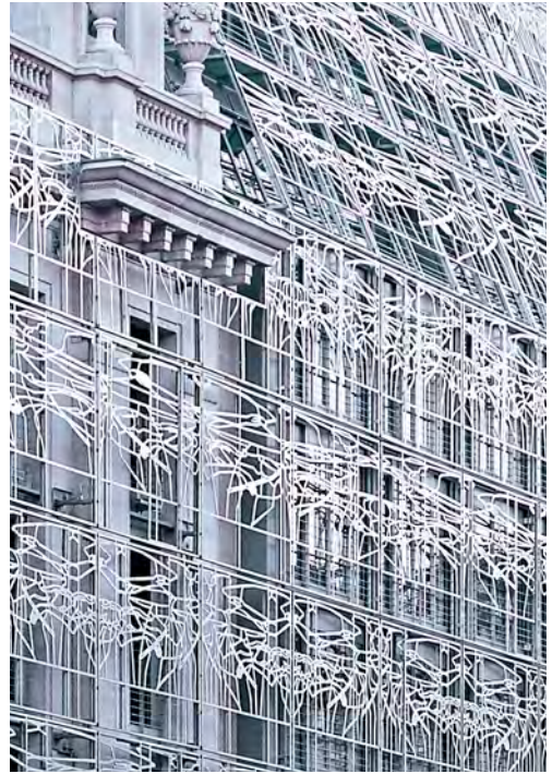
Wie ein Schleier legen sich die aus 12 mm dicken nichtrostenden Stahltafeln laser-geschnittenen Ornamente über die verschiedenen Gebäudeteile des Ministeriums für Kultur in Paris.
