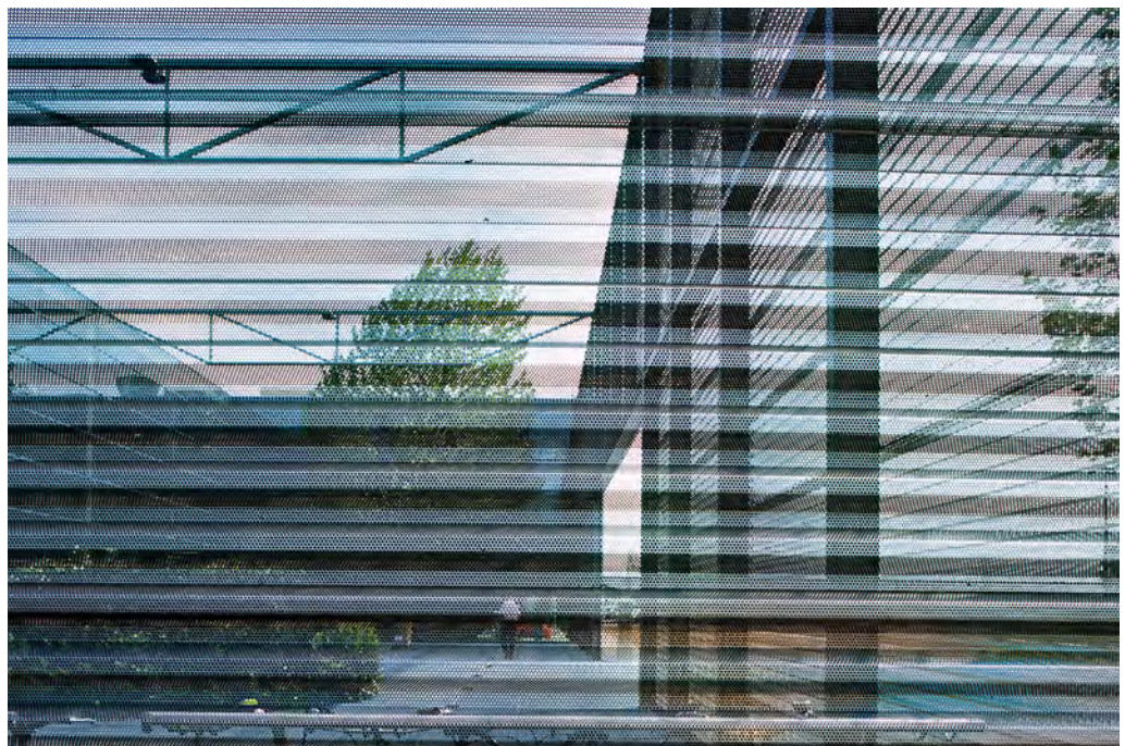
Im Pariser Flughafen Charles-de-Gaulle bilden 68 mm hohe, gelochte Trapezbleche aus nicht- rostendem Stahl den außenliegenden Sonnen- schutz der verglasten Abflughalle.
