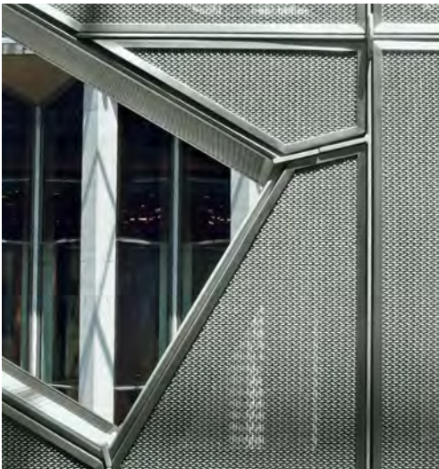
Die großflächige Wandverkleidung in der National Gallery of Victoria in Melbourne besteht aus nichtrostendem Stahlgewebe, das in umlaufende Rahmen gespannt ist.
